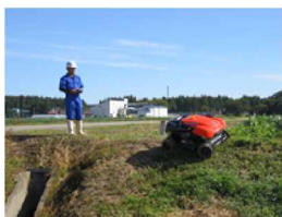
法面の草刈り作業
